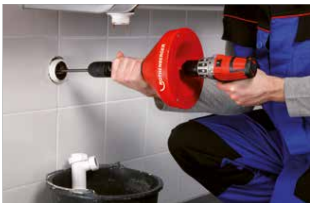
Funcionamiento eléctrico con taladro a batería
