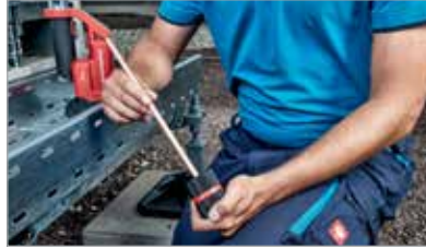
2. Escariar la parte externa del tubo
