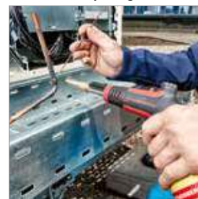
Soldadura fuerte en aire acondicionado y refrigeración
