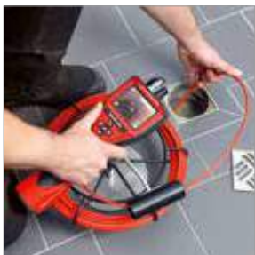
Inspección de sumideros
