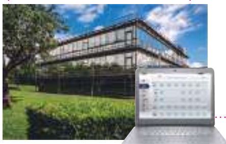
Sistema de gestão de edifícios (BMS)
