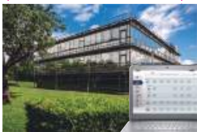
Sistema de gestão de edifícios (BMS)
